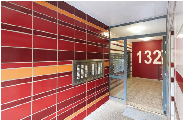
In einem der Eingänge des zwölfstöckigen Wohnhauses wurde ein zweiter Fahrstuhl eingebaut.
