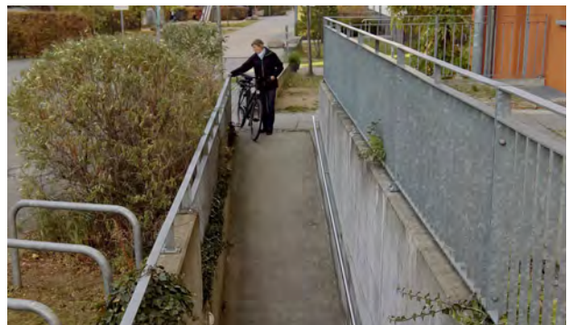
Abb.17: Rampe zum Fahrradkeller, Hamburg, Saarlandstraße
